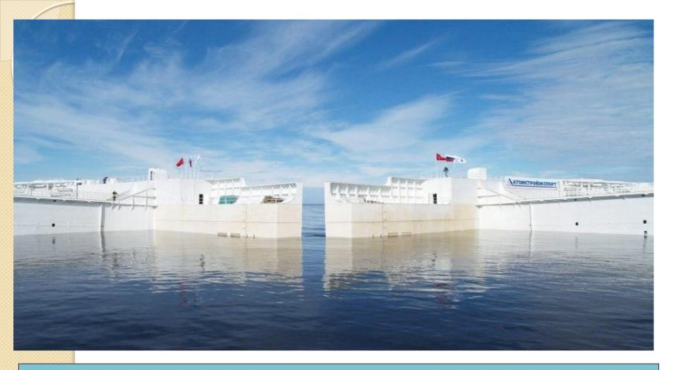
Для пропуска судов типа «река-море» предназначено судопропускное сооружение С-2. Судопропускные сооружения - это система с подходными каналами и уникальными затворами, подъемным мостом и тоннелем.
