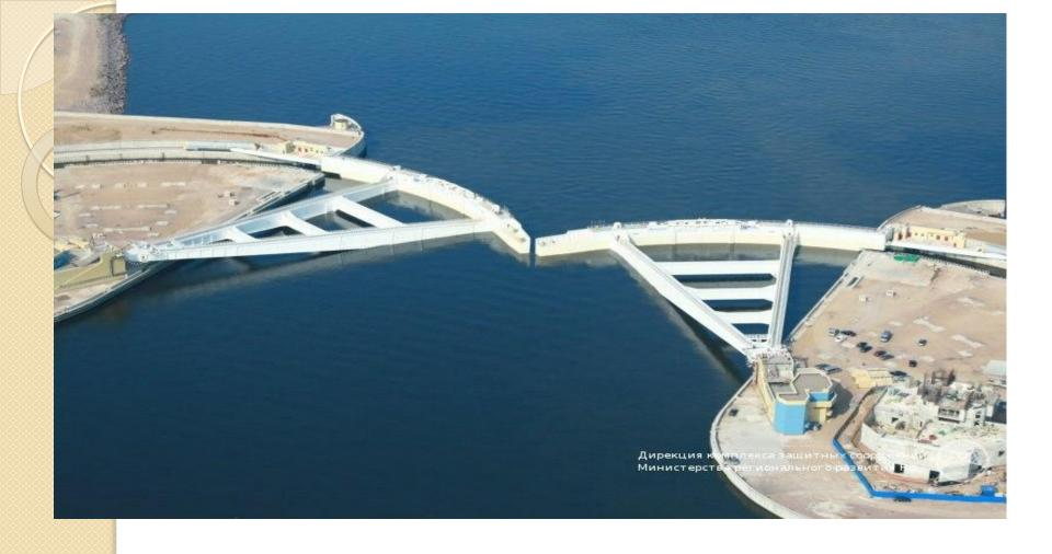
Для прохода крупных грузовых судов и больших круизных лайнеров (водоизмещение которых составляет около 100 тысяч тонн) предназначено судопропускное сооружение С-1.
